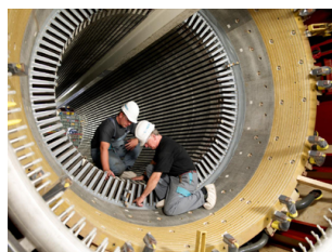
radovi na statoru generatora
